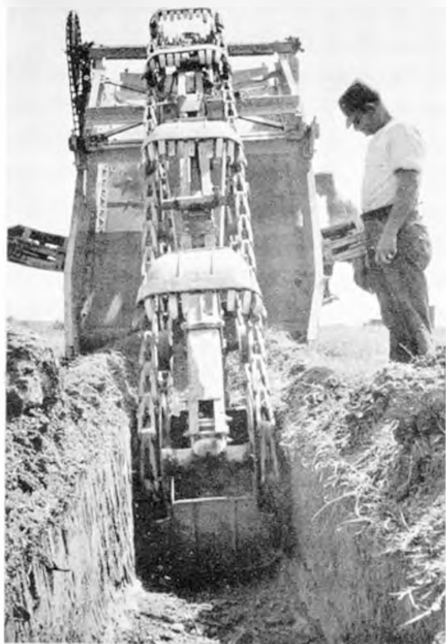
LA NUEVA CIUDAD DE LA "COOPERATIVA EL ROSARIO" CONTARÁ CON UN MODERNO SISTEMA DE ALCANTARILLADO
