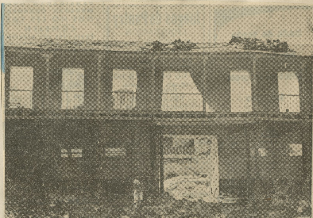
...he aquí el estado de ruina en que quedó una de las galerías altas del antiguo convento de Santa Clara de Asís después que los trabajadores de OP derrumbaron la construcción moderna anexa sin miramientos de ninguna clase, empleando bull-dozers y cables de acero.
