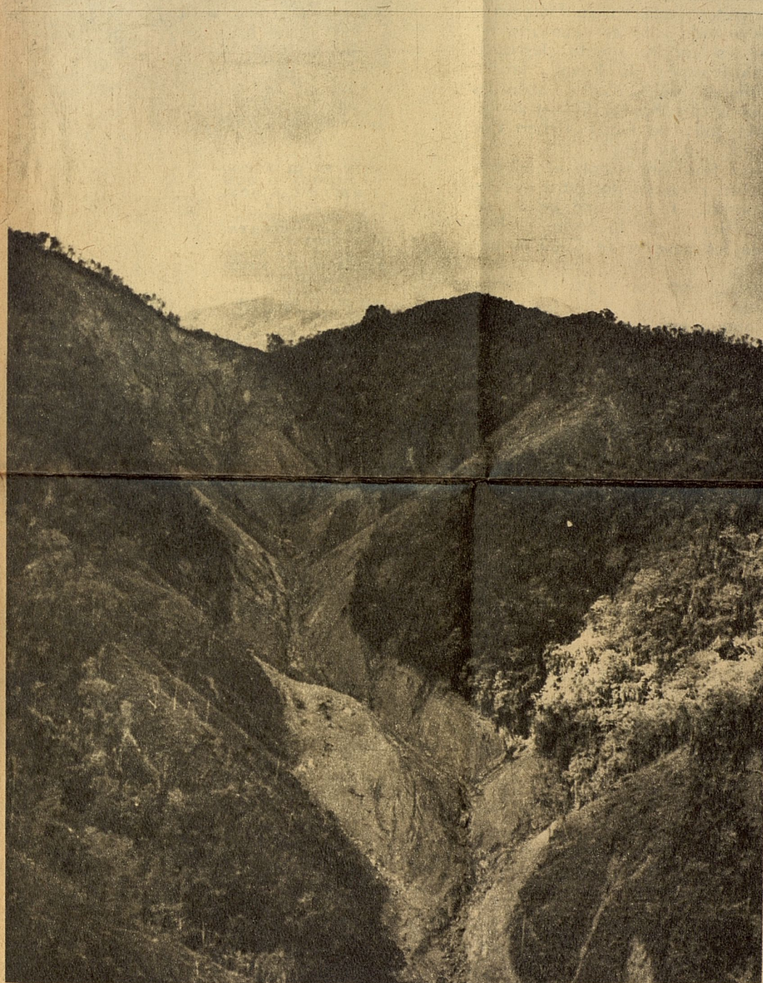
EN LA MONTAÑA DEL BRAZON DE SANTA ANA, NO LEJOS DEL TURQUINO, UNA LADERA SE DESPRENDIO ESPECTACULARMENTE. NOTESE LA DEFORESTACION DE LAS LADERAS CERCANAS AL DESASTRE. BAJO ESTAS PIEDRAS DERRUMBADAS PERECIERON ALGUNAS FAMILIAS CAMPESINAS.
