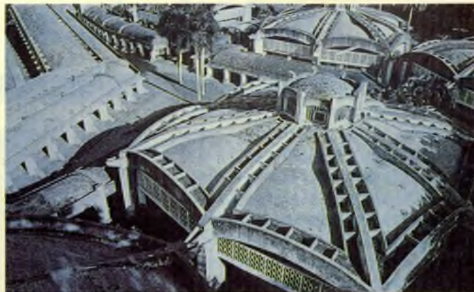
Vista aérea de la Escuela de Danza Moderna (Cubanacán).
