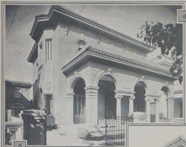
VISTA DEL FRENTE DE LA CASA
