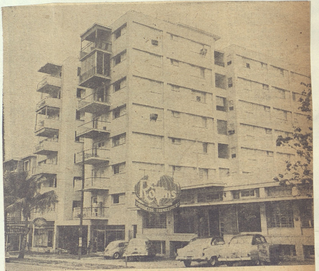
EN RANCHO BOYEROS entre Tulipán y Conill se ha construido este edificio de siete pisos, con 25 viviendas, por el arquitecto L. Gómez Fantoli. Consta de 3,848 metros y una inversión superior a $240,000.00.
