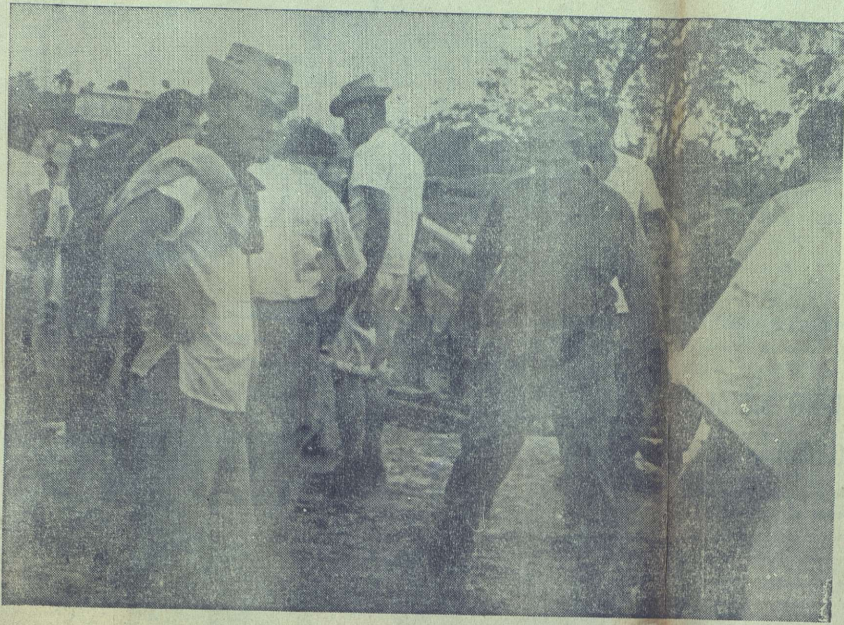
El dirigente nacional del Sindicato Azucarero, Conrado Béquer, observa con detenimiento los daños causados por el huracán en el puente La Rioja, en el tramo de Buenaventura a Holguín.
