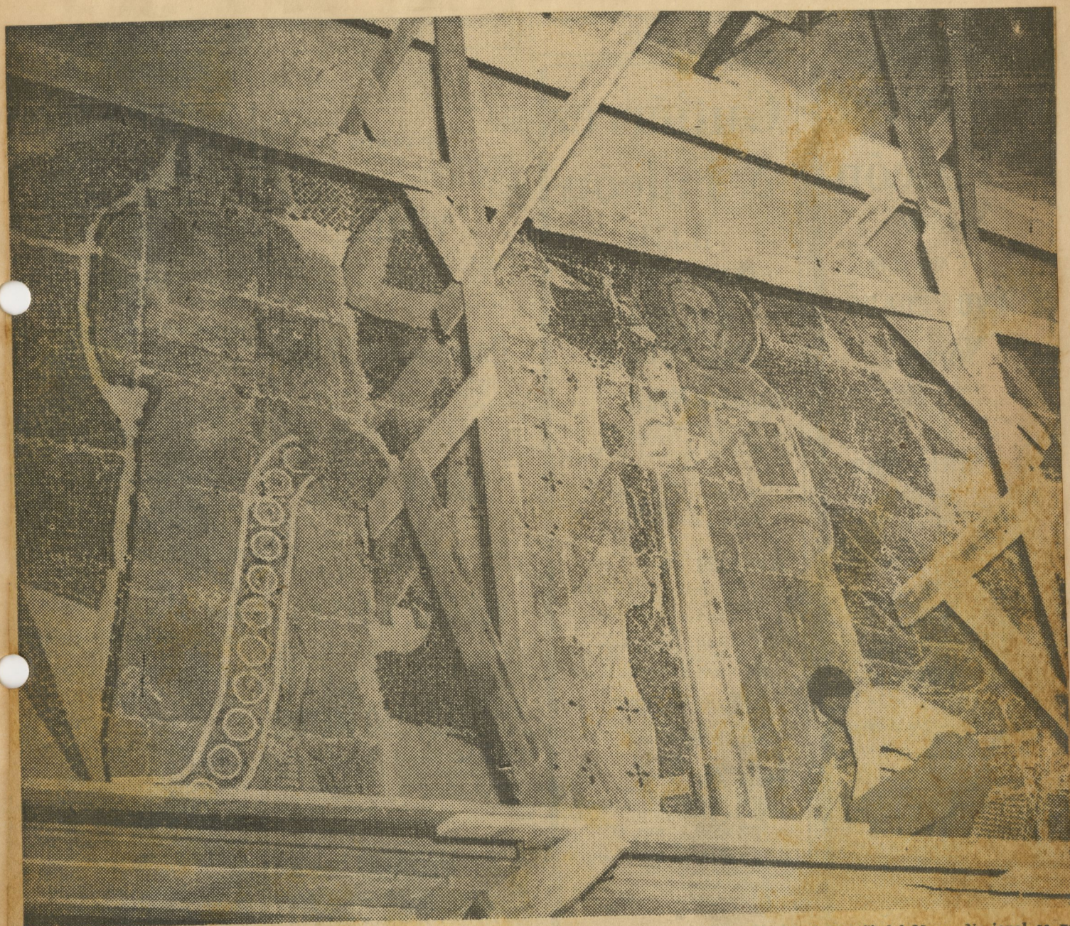
El mural ejecutado con mosaicos bizantinos por el eminente pintor Enrique Caravia en el vestíbulo "José Martí" del Museo Nacional se ve en el proceso de unir las juntas de los paneles-fragmentos (320 en total). Cerca de un millón de pequeños cubos que miden un centímetro cuadrado por 6 milímetros de espesor, cubren la superficie de 80 metros cuadrados con una composición simbólica de la evolución o etapas de las artes clásicas y contemporáneas. Es la primera obra de su tipo y de sus dimensiones que existe en nuestro país. (Romárico Heredia, uno de los colaboradores de Caravia, aparece trabajando en el andamio).
