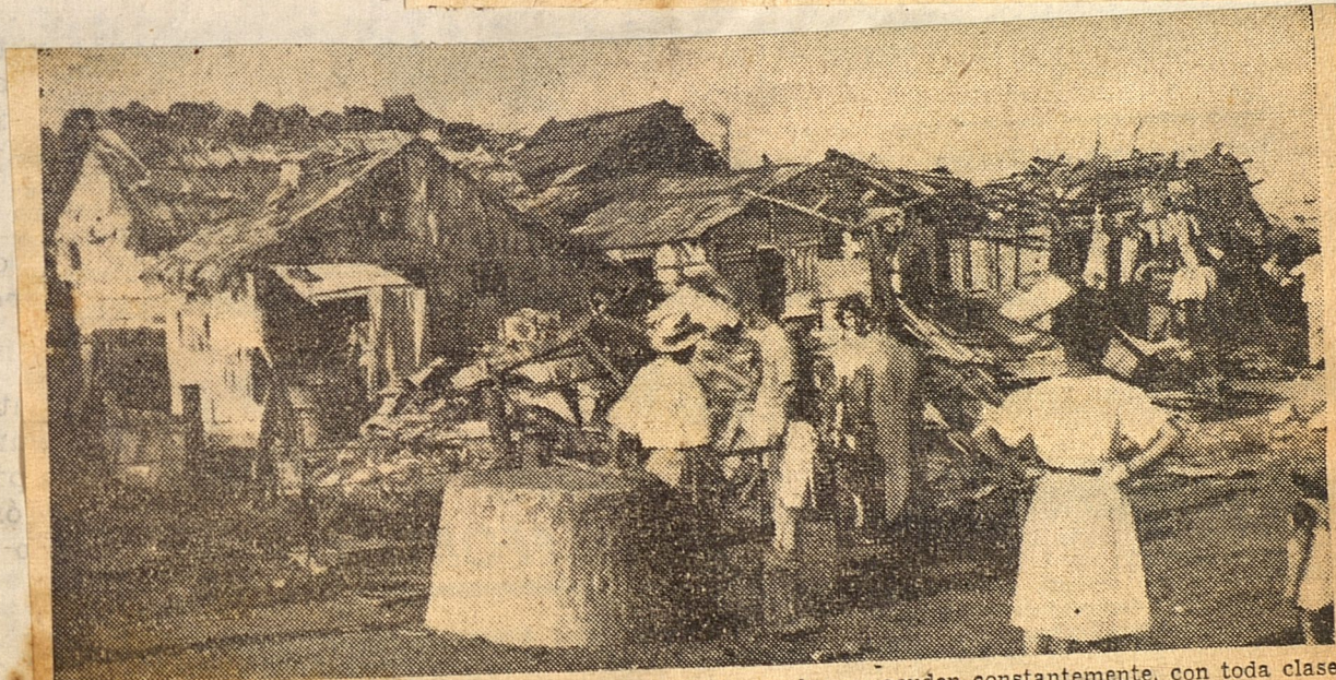
La única toma de agua que hay en el barrio Isla de Pinos, a la que acuden constantemente, con toda clase de vasijas, los vecinos del lugar.
