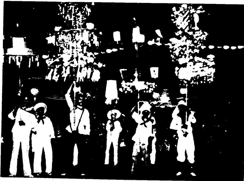
Las farolas de "Los Mambises" inician la marcha.
