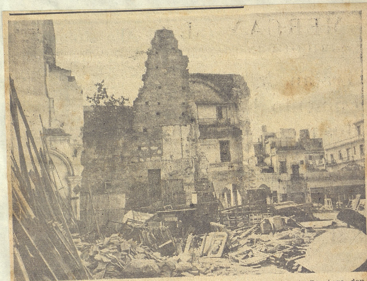
Aspecto de las demoliciones del edificio antiguo del Convento de Santo Domingo, donde más tarde estuvo la Universidad y el Instituto de La Habana. Toda esta área servirá para levantar un edificio de diez pisos para el Banco Nacional de Cuba, haciéndose importante mejoramiento urbano.
