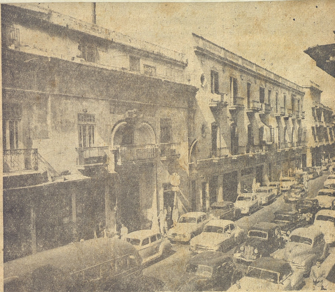
En esta vista de conjunto aparecen en toda su extensión los edificios que pronto serán derribados. Sus fachadas dan hacia la calle Mercaderes, al fondo del Palacio Municipal donde puede apreciarse en la calle lo difícil que resulta el tránsito de vehículos y las dobles hileras de vehículos.
