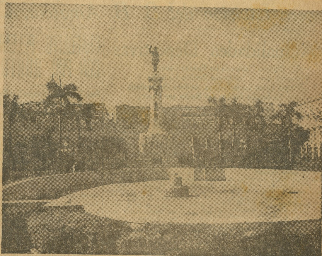
En el centro del Parque Zayas, ante la estatua del ex Presidente se halla esta fuente de gran capacidad y dimensiones. El muro que la rodea es demasiado alto si se tiene en cuenta que lo que se pretendió hacer fué un estanque.
