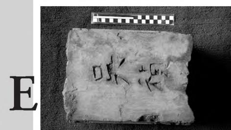
Entre las columnas aparecen tres tipologías de piezas o celosías, prefabricadas en hormigón débil vaciadas en moldes, colocadas de manera que debían cerrar el perímetro entre una columna y otra, cuyos diseños recuerdan caracteres chinos. En solo algunos sectores del sitio se pudieron localizar varias colocadas en su sitio original, y de otros casos solo quedaban fragmentos, la mayoría dispersas por todo el espacio fúnebre.
