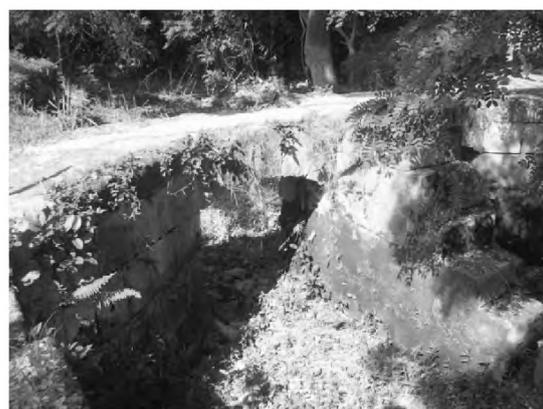
Muro sobre el que descansaba el mecanismo de salida del agua del río al canal cercano a la represa de El Husillo. Presencia de moho y plantas.
