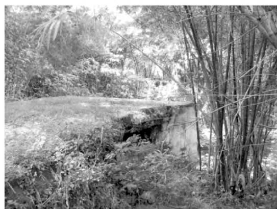
Único arranque de la Represa de El Husillo que sobrevive. A. Muestra de la unión entre la parte antigua y la de concreto que se agregó para su consolidación luego de haber sido destruida.
