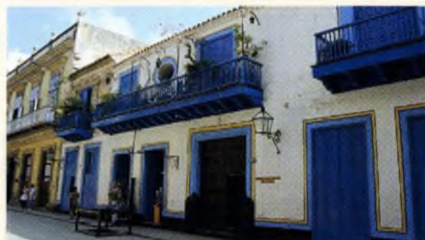
Fachada de la casa de Obispo 117-119, Habana Vieja.
