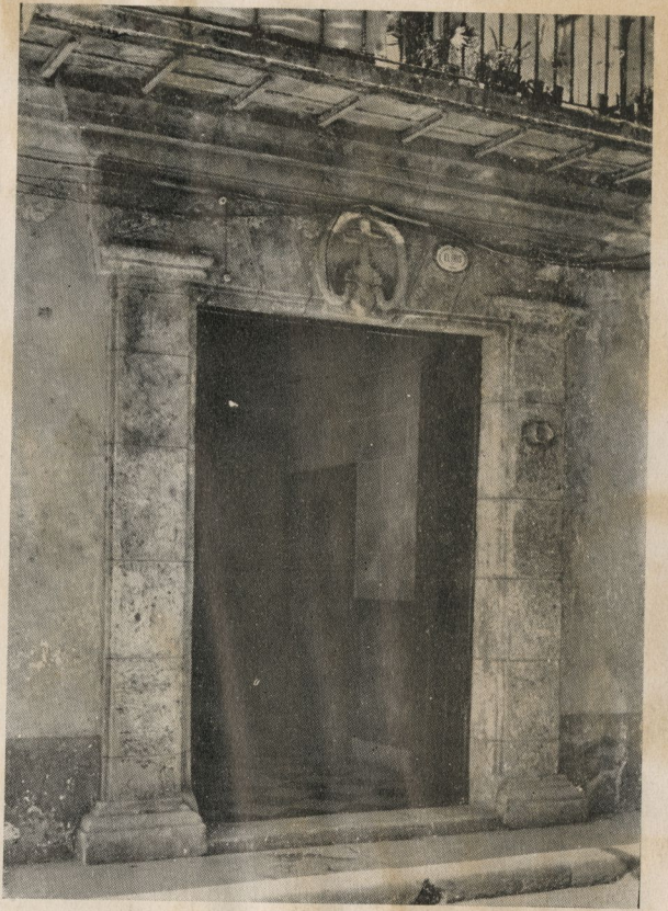
Edificio situado en la calle de los Oficios número 2, que fué el primer Palacio Episcopal que tuvo La Habana.
