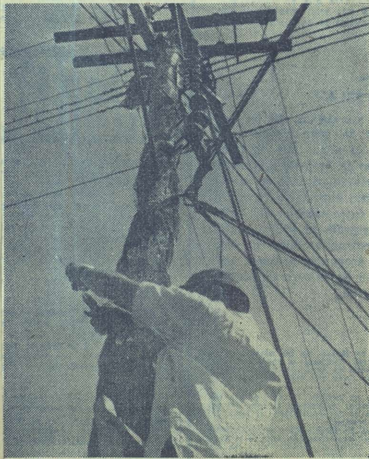
Un electricista de la Brigada trabaja en los tendidos eléctricos del lugar.
