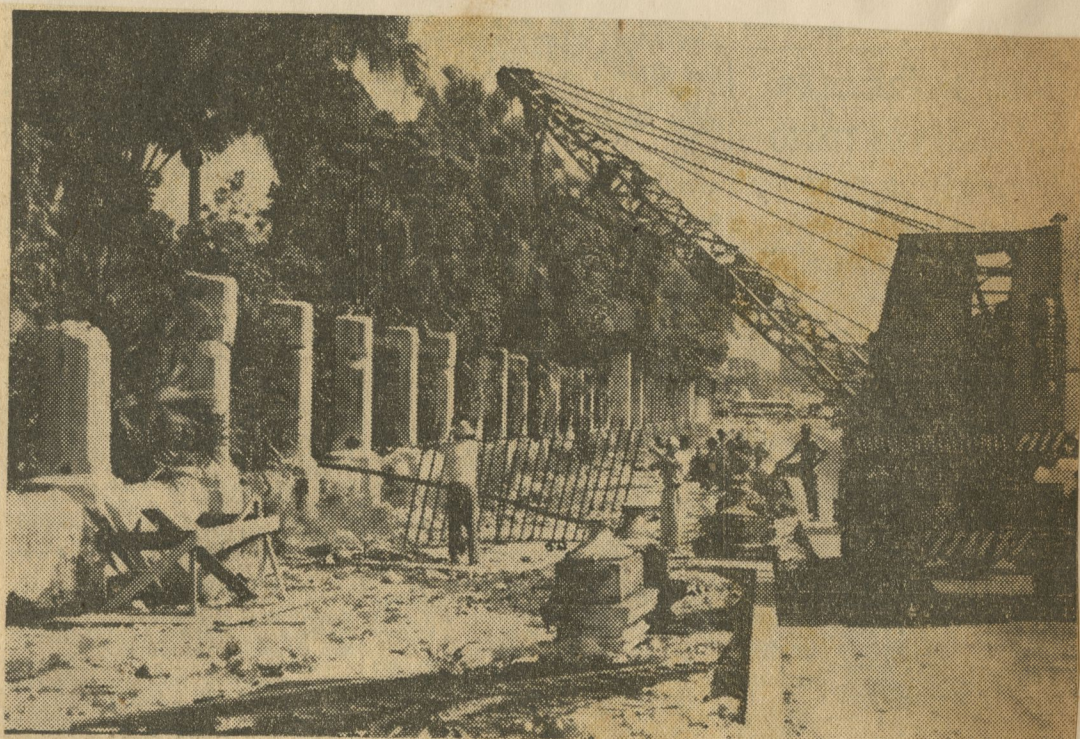
DERRIBAN LA ANTIGUA CERCA DE LA QUINTA DE LOS MOLINOS. — Hombres y máquinas del Ministerio de Obras Públicas se unen en un esfuerzo por arrancar las antiguas rejas de la Quinta de los Molinos, para poder llevar a cabo la ampliación de la avenida de Carlos III, en tramo que va desde Infanta al Príncipe. (Foto de la Torre).
