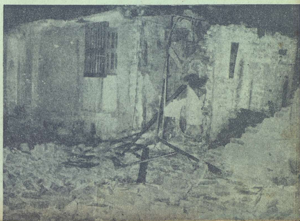
En la foto puede apreciarse una parte de las construcciones del central "Elia", en Camagüey, convertida en escombros por los efectos del violento huracán que azotó esta zona.
