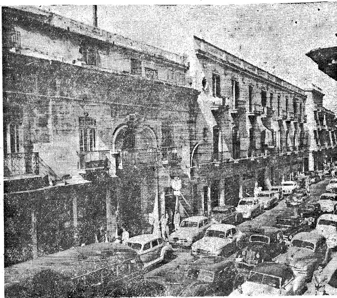
En esta vista de conjunto aparecen en toda su extensión los edificios que pronto serán destruidos. Sus fachadas dan hacia la calle Mercaderes, al fondo del Palacio Municipal donde puede apreciarse en la calle lo difícil que resulta el tránsito de vehículos y las dobles hileras de vehículos.
