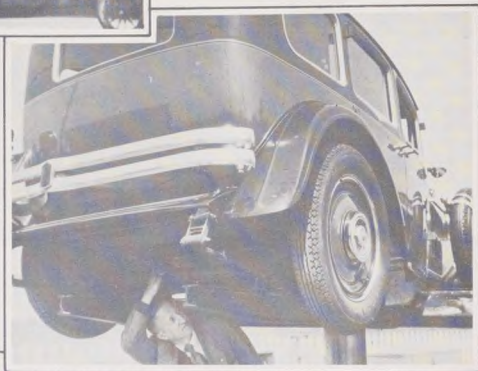
Una vista de la parte trasera del "Misterio" donde muestra un eje tan sencillo como el delantero de un carro corriente.
