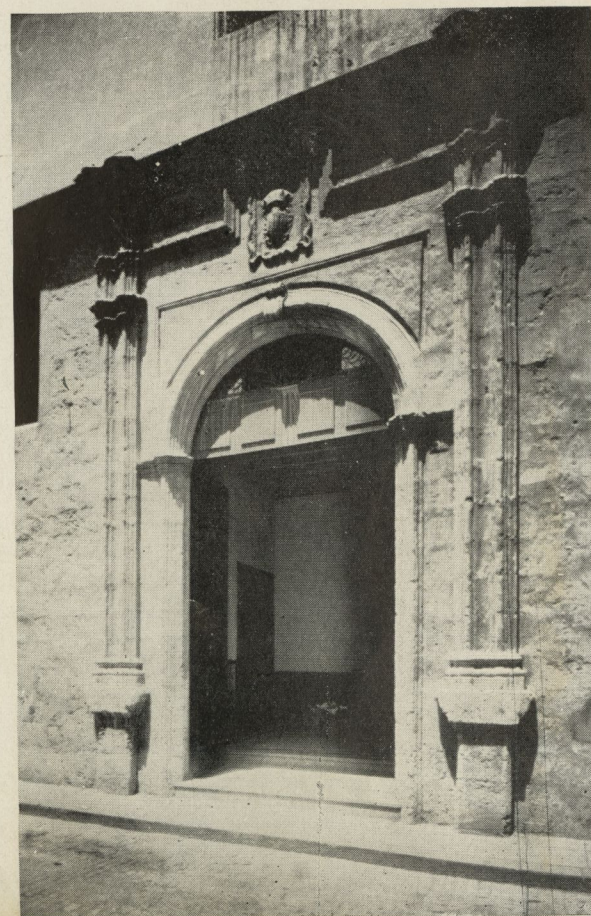
Detalle de la puerta lateral de la iglesia de la Merced que da a la calle de su nombre.
