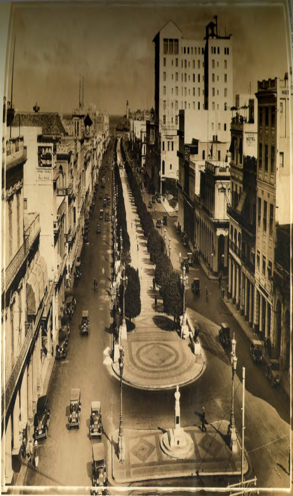
Vista panorámica del Paseo del Prado. Primeras décadas de este siglo.
