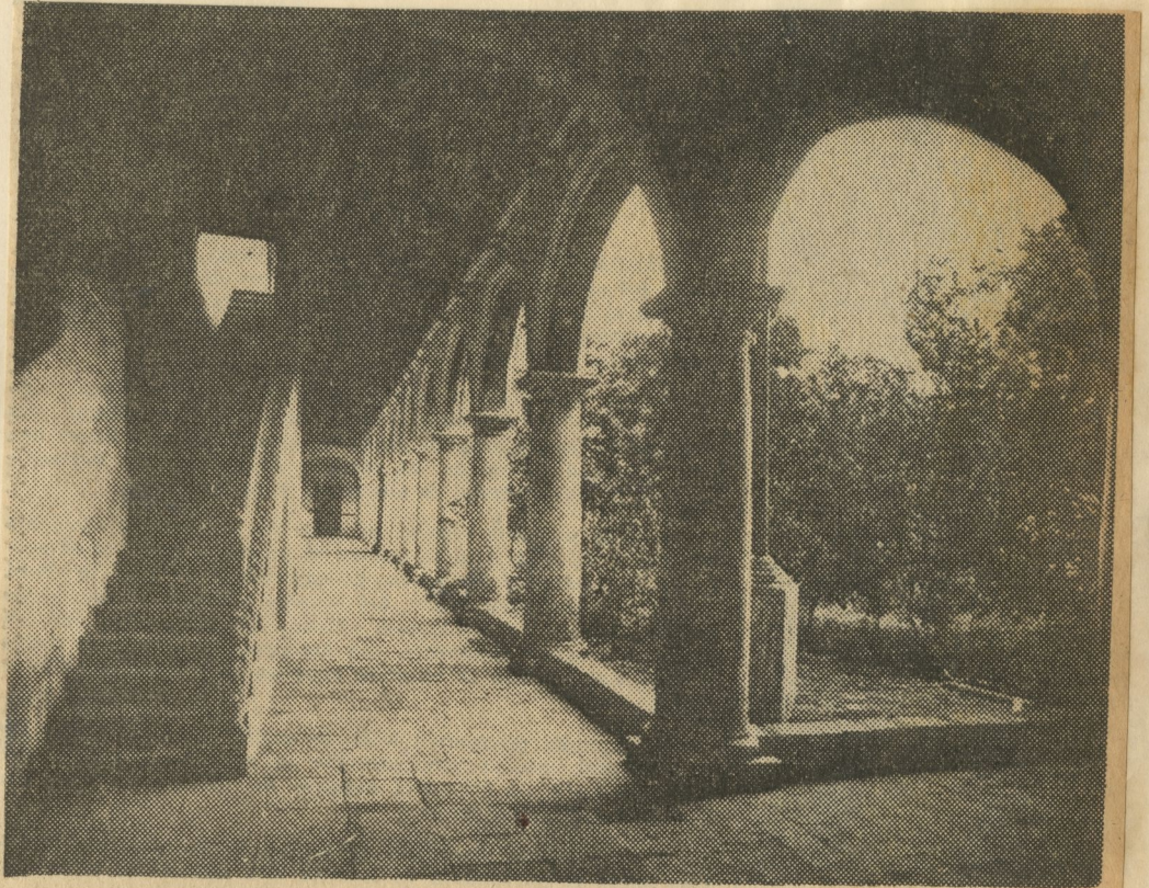
El piso de los corredores del convento era de piedra. Al adaptarlo a oficina los hicieron de granito. Ahora se le devolvirá su primitivo material. Volverá a ser de piedra.
