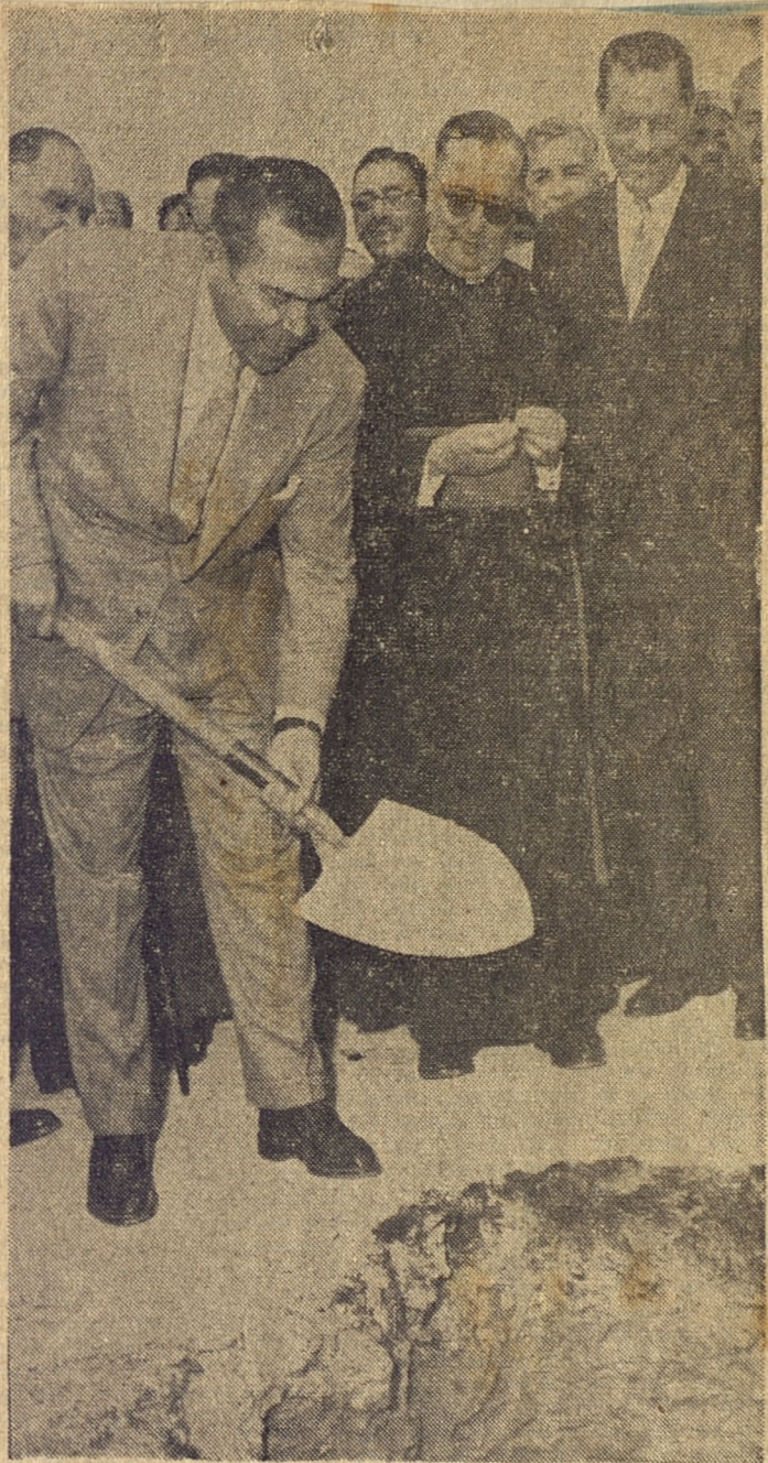
El Presidente Batista echando la primera paletada de tierra sobre la arquilla metálica sepultada en el punto de inicio de la obra.
