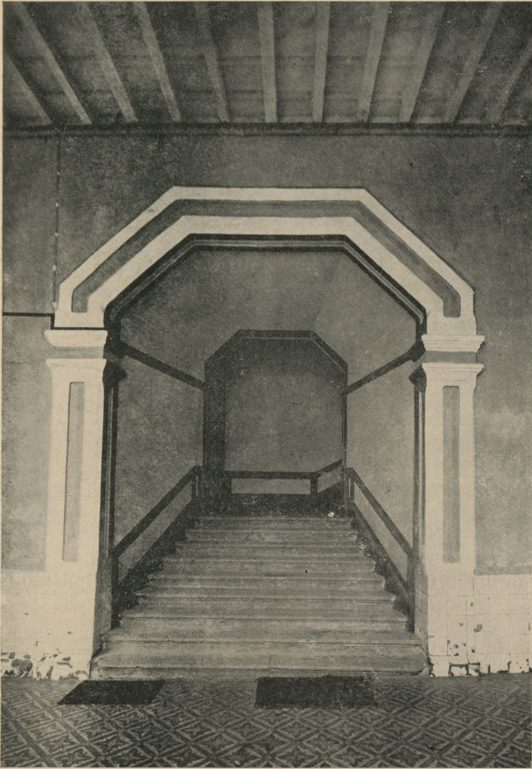
Hueco de entrada a la escalera principal. Seminario de San Ambrosio.
