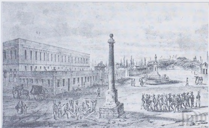
VISTA DE LA ANTIGUA CARCEL. Este edificio que estaba situado en la primera cuadra del Paseo del Prado ¡por fin! va a ser sustituido por el severo Palacio de Justicia, que construye el Provisionalato.
