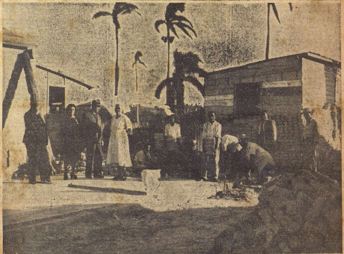
Progresan las tareas de levantar las casas derribadas por el ciclón del 18 de octubre. En la parte superior se muestra una de las treinta casas reconstruidas por la Comisión de Asistencia y Rehabilitación en los barrios extremos de La Habana. Es de madera y el techo está forrado con papel especial. Los pisos son de cemento. En la parte inferior, el arquitecto Febles Valdés, director de la Comisión, da instrucciones al personal para emprender las labores de reconstrucción de una casa de mampostería del reparto La Bien Aparecida, con gran alegría por parte de sus moradores.
