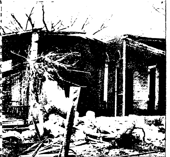
Destrozos causados por el huracán en el pueblo de Bolondrón.
