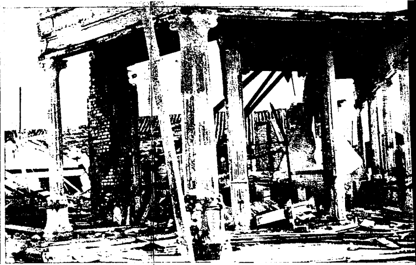
Esto fué uno de los mejores edificios del pueblo de Unión de Reyes, que ahora sólo tiene unas columnas agrietadas y en peligro de derrumbarse a cada instante...
