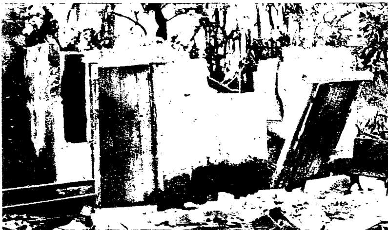
Una escuela de Sabanilla destruida por la furia del meteor.
