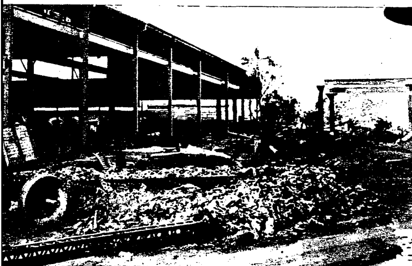
Esta es una de las inmensas naves de la Fundición Perret, de Unión de Reyes, donde ganaban el pan medio millar de obreros que ha quedado como toda la fábrica desmantelada y deshecha por el ciclón.
