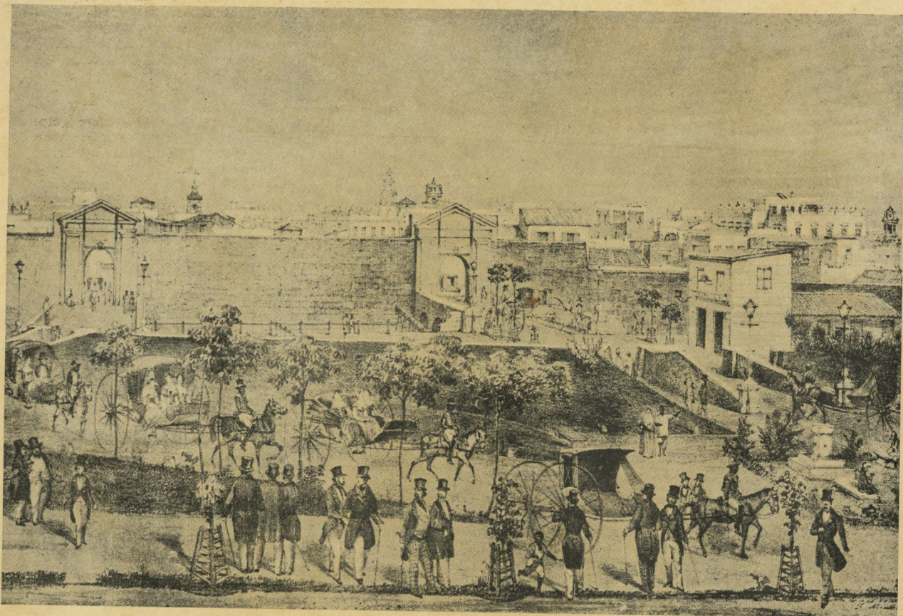
Puertas de Monserrate de las antiguas murallas que circundaban la Habana. (Grabados de F. Mialhe).
