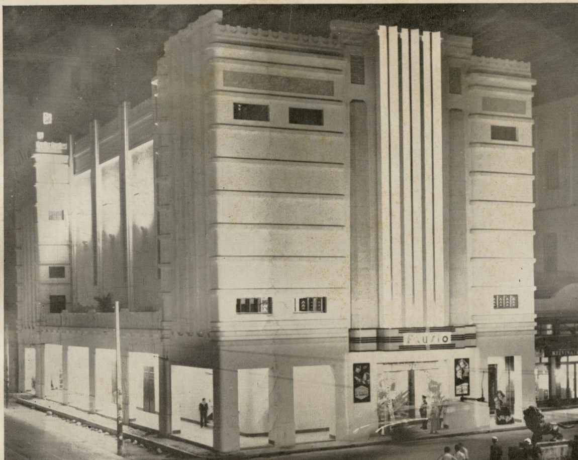
Vista general del nuevo teatro Fausto.—Arquitecto S. M. Parajón.
