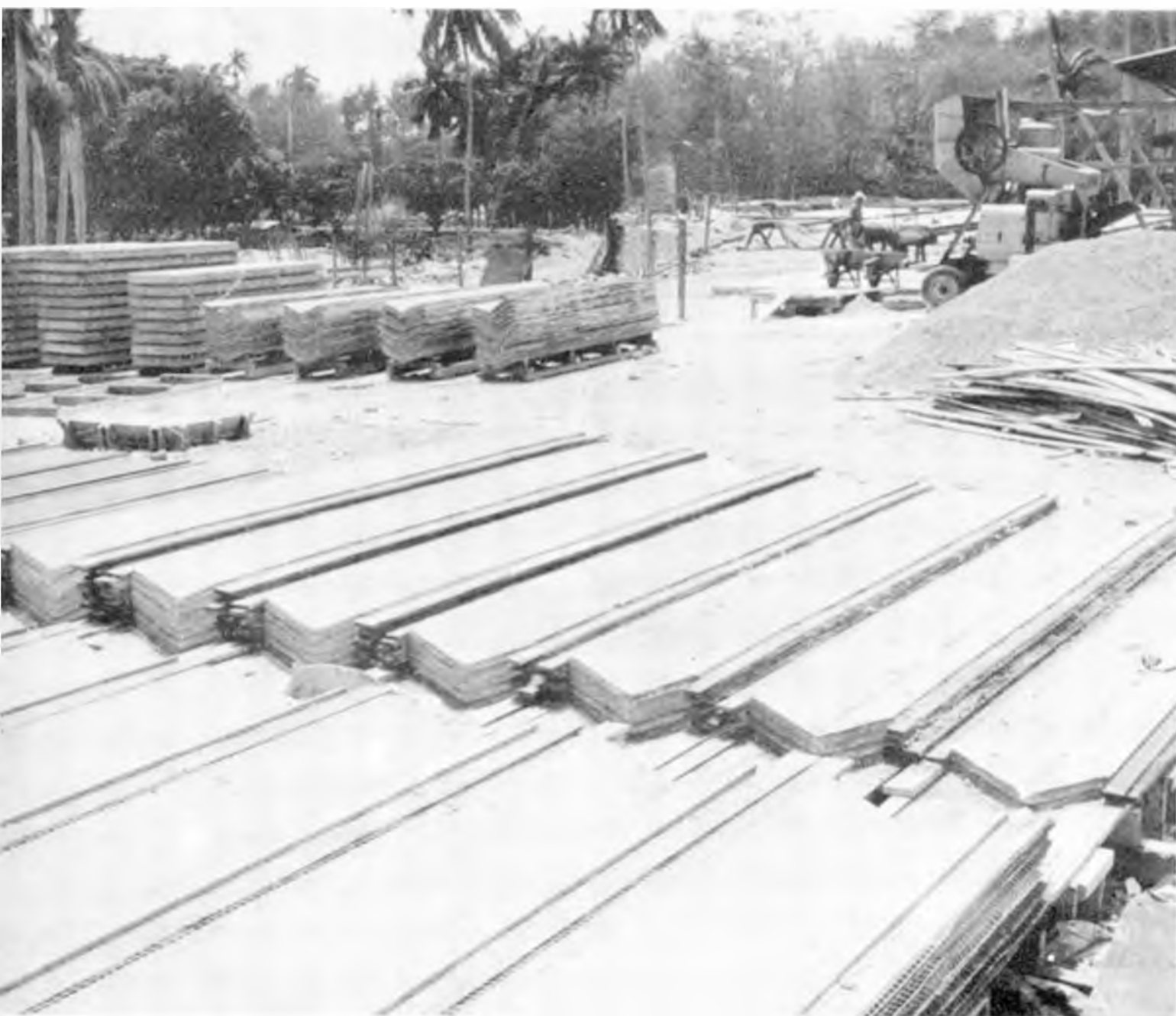
Obreros voluntarios construyen también los techos prefabricados para las nuevas viviendas de "La Chirusa".
