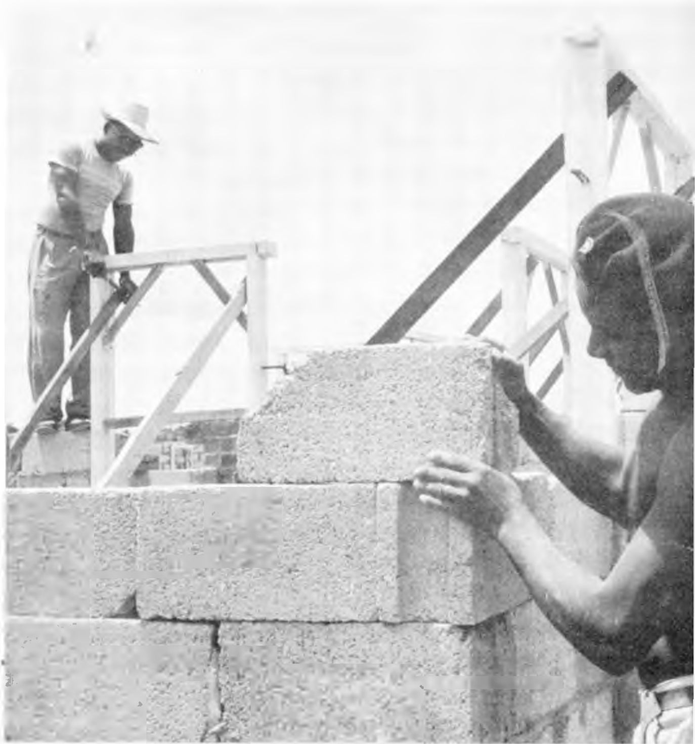
Bloque a bloque, con el esfuerzo denodado de un pueblo, con albañilería, experiencia y con otros improvisados, se fabrican las casas.
