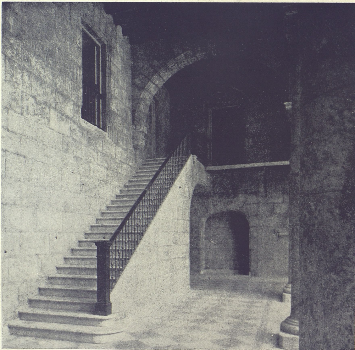
Palacio del Ayuntamiento. Escalera del fondo.—Govantés y Cabarrocas, arquitectos. Contratistas: J. A. Mendigutia - Raúl Simeón.
