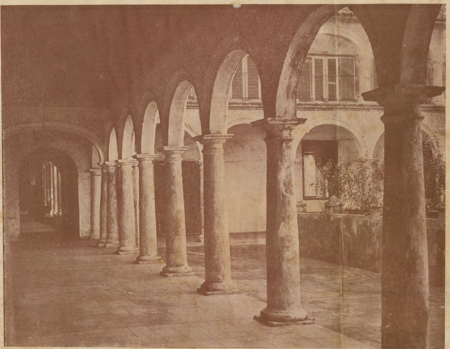
EL VIEJO CONVENTO DE SANTA TERESA.—Galería de columnas alrededor del patio central. (Fot. López Ortiz).
