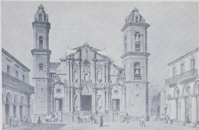
LA CATEDRAL DE SAN CRISTOBAL DE LA HABANA Y PARTE DE LA PLAZA DE SU NOMBRE Espléndido grabado en el que aparecen, no sólo la Iglesia Catedral, tal como se encontraba a mediados del siglo XIX con las primitivas terraza y escalinata, sino también las casas del Marqués de Aguas Claras (izquierda), y del Marqués de Arcos (derecha), según dibujo de Hoefler, litografiado sobre piedra por Eugenio Cicéri y Felipe Benoist, impreso por Lemercier, París, y editado en 1854 por M. Knoedler, de Nueva York.
