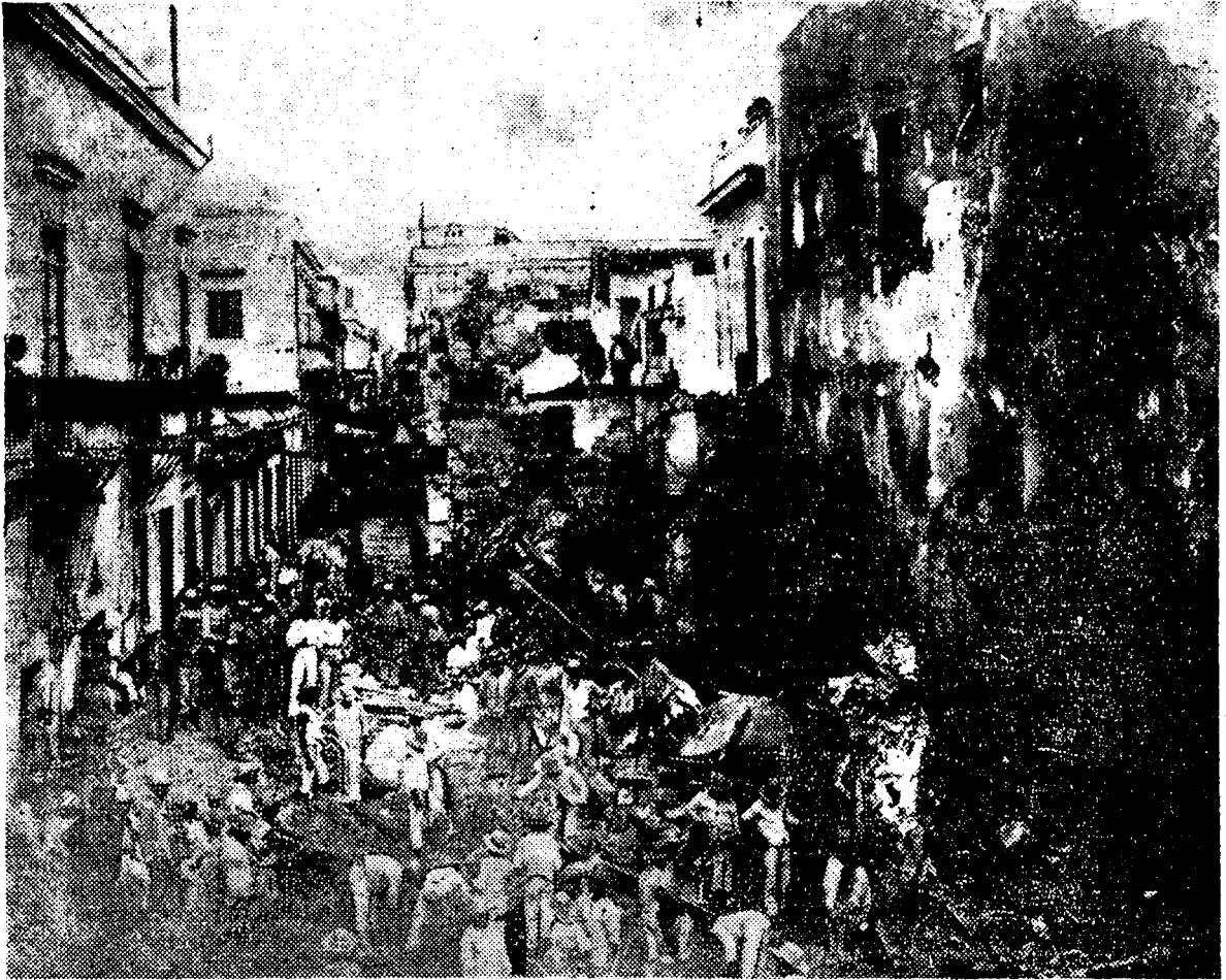
Lo que sólo quedó en 1895 del famoso taller de Estanillo. Cuadrillas de obreros escombrecan el lugar, mientras en uno de los extremos de la calzada del Monte, próximo a la calle de Matadero, se ha situado un grupo de voluntarios españoles. Al fondo, sobre la única parte del edificio que no fué destruída, el alcalde español mostrando su bastón con borla y un escribano, que hacía apuntes de los destrozos causados.
