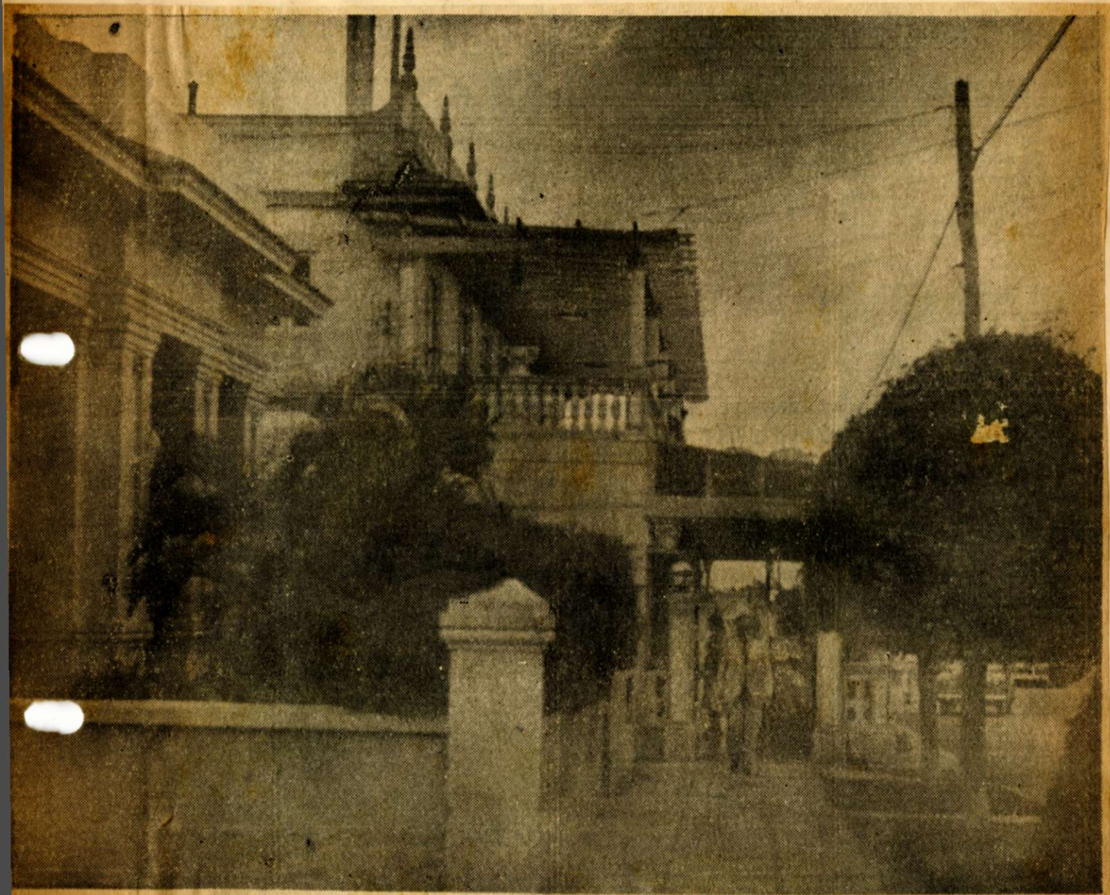
* Digno de que Ripley lo incluyera en su famosa colección de rarezas tituladas "Créalo o no lo crea", es este caso de antiurbanismo existente en el término municipal de Marianao. No sólo eliminaron el jardín, desacatando las regulaciones de construcción, sino que también se adueñaron de la acera. El peatón puede optar por un estrecho pasillo junto al contén o atravesar el restaurant.
