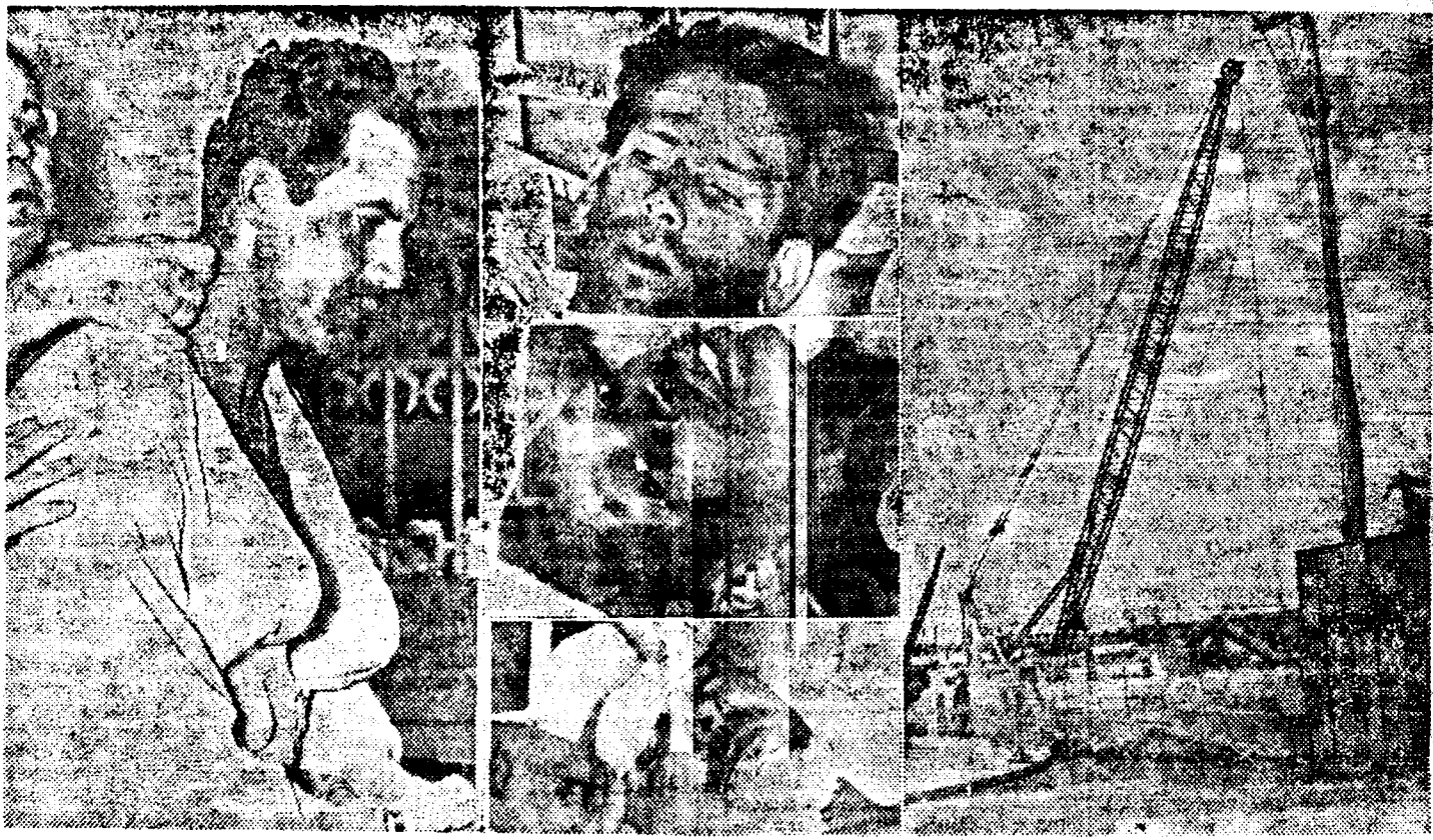
Ofrecemos esta combinación gráfica del derrumbe ocurrido esta tarde en el Túnel de la Habana del Este, durante se realizaban excavaciones, resultando cinco trabajadores heridos. En primer término el capataz Laureano Valdés Nager cuando era atendido por el Dr. Castañeda en la Clínica "Santo Tomás"; después los trabajadores Francisco Castro Rodón, José Antonio Percedo Morales y Roger Clemente Llerena, heridos en el derrumbe. Finalmente aparece la grúa que, debido a partirse el cable, ocasionó el suceso espectacular. (Foto de P. Pérez).
