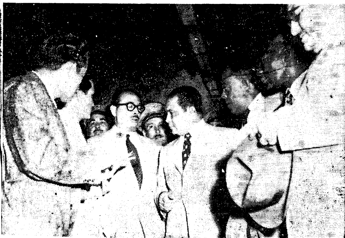
Momentos en que el general Batista, presidente de la República, junto con el ingeniero Varela, hace un aparte para charlar con los periodistas en el acto de inspección al túnel que unirá La Habana y Marianao, que será inaugurado dentro de pocos días, según anunció.
