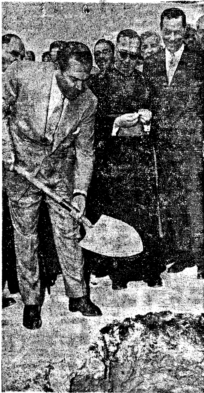
El Presidente Batista echando la primera paletada de tierra sobre la arquilla metálica sepultada en el punto de inicio de la obra.
