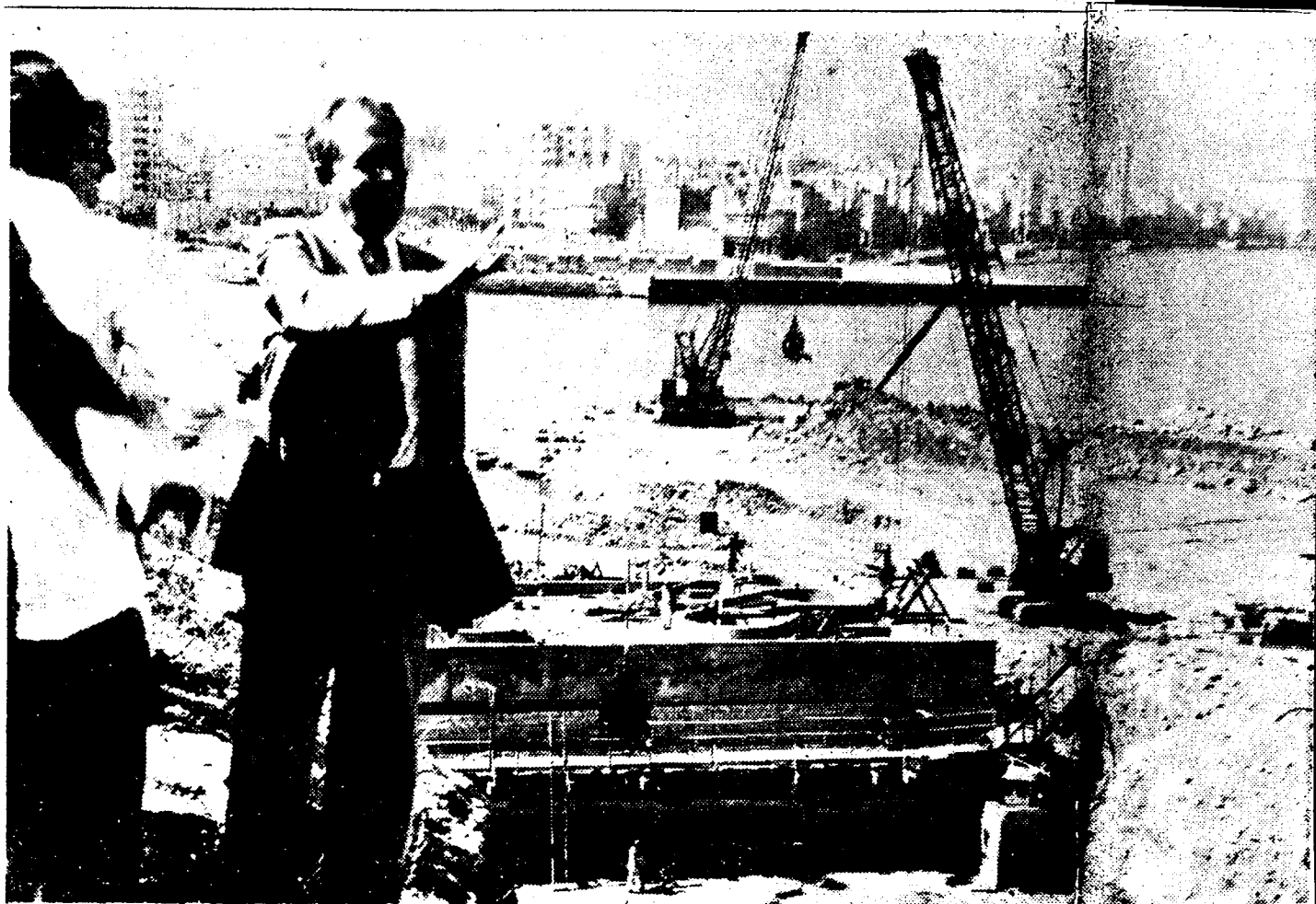
LAS OBRAS DEL túnel de La Habana, cuyas zonas de salidas serán embellecidas, fueron inspeccionadas por el presidente de la Comisión de Fomento Nacional, ingeniero Amadeo López Castro, en sesión de un grupo de ingenieros y representantes de la empresa constructora.
