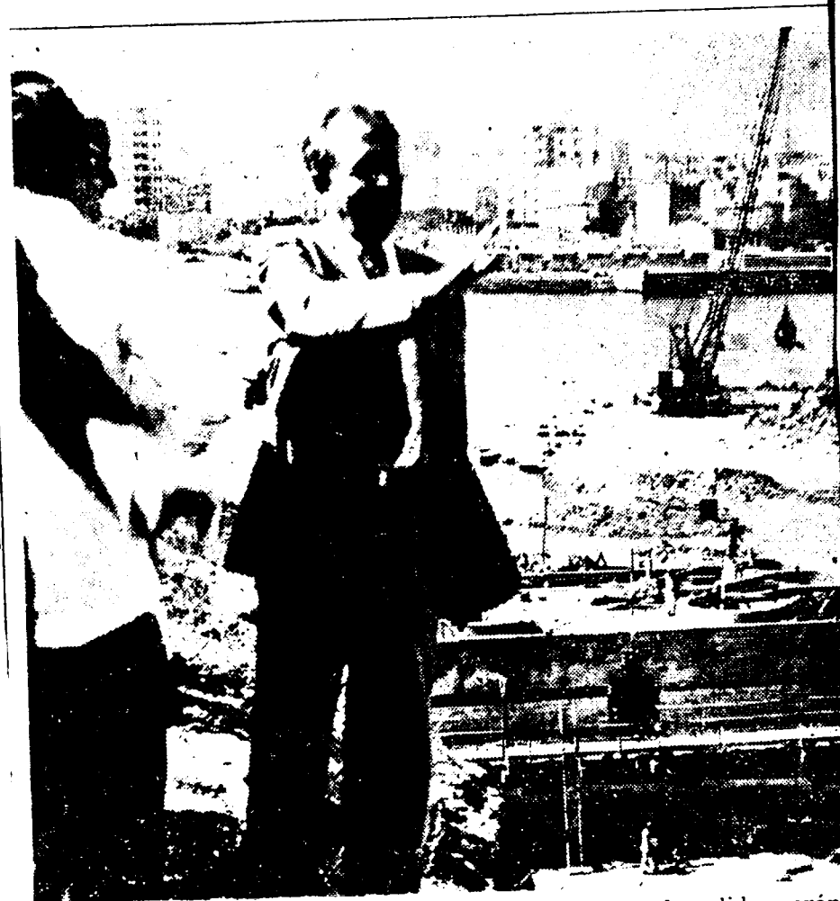
LAS OBRAS DEL túnel de La Habana, cuyas zonas de salidas serán el presidente de la Comisión de Fomento Nacional, ingeniero Amadeo, ingenieros y representantes de la empresa co
