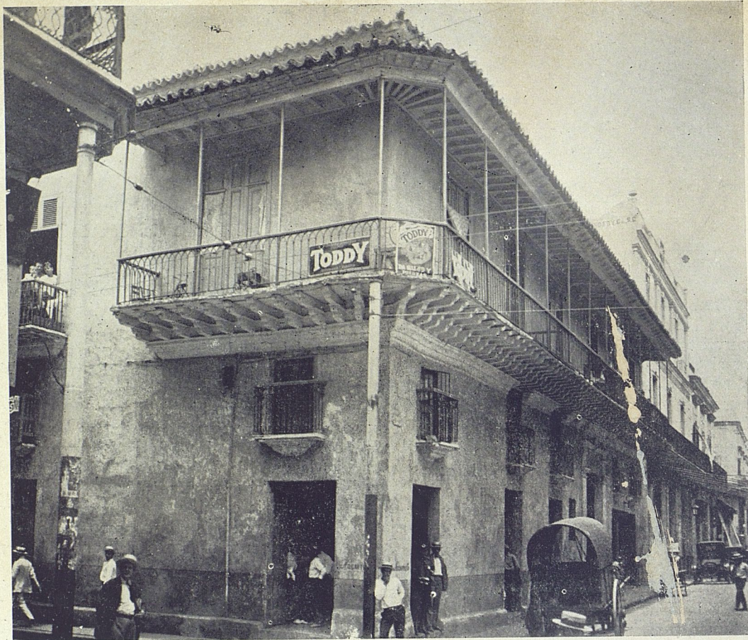
La vieja casa Oficios 76 esquina a Luz, nos muestra su típico balcón sostenido por dobles cabezas de vigas, sirviendo a la vez que de refuerzo, de motivo de ornamentación.
