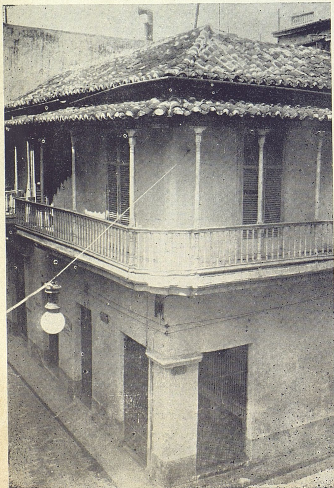
La vieja casa Oficios 76 esquina a Luz, nos muestra su típico balcón sostenido por dobles cabezas de vigas, sirviendo a la vez que de refuerzo, de motivo de ornamentación.
