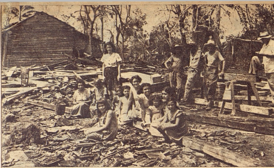
¡Por esta zona de Bolondrón pasó el huracán convirtiendo en ruinas la casa donde se albergaba esta numerosa familia que ahora llora la catástrofe que perdurará por mucho tiempo sobre ella!...
