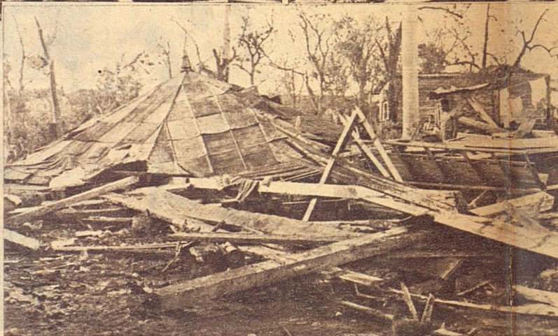
Pocas son las edificaciones que han quedado en pie en Unión de Reyes... La inmensa mayoría son como ésta, montañas de maderas, hierros y ladrillos!...
