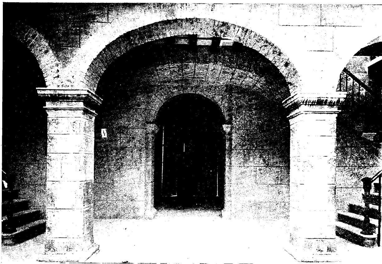
CASA DEL CONDE DE CASA BAYONA. GALERIA DE LA PLANTA BAJA. ESCALERAS.
