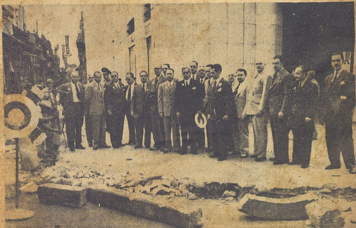
Destacados miembros de la Asociación de Comerciantes y Banqueros de la Calle del Obispo rodean al ministro de Obras Públicas, ingeniero Evelio Govantes, pocos momentos después de comenzadas las obras de ampliación de aceras y pavimentación en esa importante vía capitalina. Invitados especialmente por el señor José Carrera, presidente de la institución, asistieron a este acto el doctor Pérez Cubillas, gobernador del Distrito 25 del Rotary Club; el señor Edelberto Carrera, presidente del Club de La Habana, y el ingeniero Horacio Navarrete, distinguido miembro del Club. Aparecen también en la fotografía el jefe del distrito de la ciudad de La Habana, ingeniero Francisco Saladrigas, y el señor Charles Pemberton, secretario particular del Ministro de O. P.
