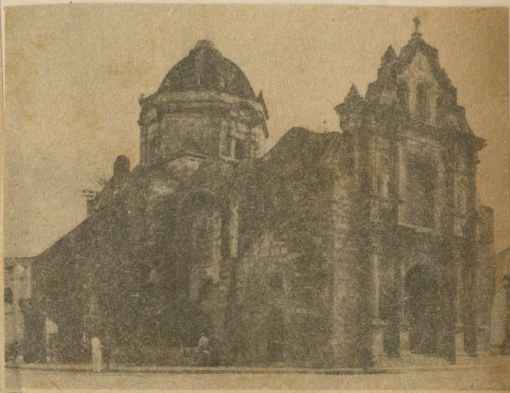
Un aspecto de la valiosa fachada que tiene casi trescientos años de construída. Ahora ha sido reparada.
