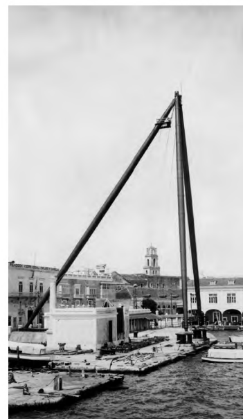
La Machina con su estructura de forma trípode ya sustituida en metal
