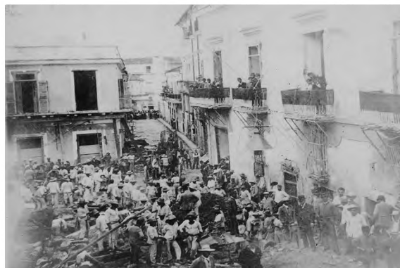
Imagen también tomada por José Gómez de la Carrera, esta vez desde la calle San Ignacio. En el pie de esta fotografía, publicada en el diario La Discusión como parte de la cobertura de los hechos ocurridos en mayo de 1890, se llama la atención sobre el estado, al fondo, de la ferretería de Isasi, lo que demuestra que lo que se incendió y estalló fue el almacén de ese establecimiento, ubicado en la esquina de Mercaderes y Lamparilla, pero en la acera contraria (Fondo fotográfico de la Biblioteca Nacional José Martí)
