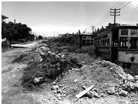
Enterramiento de los tranvías
