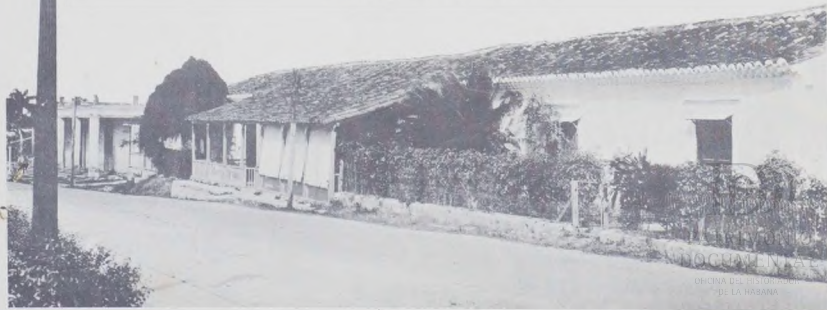
La casa solariega de los Condes de Casa Bayona, tal como se conserva en la actualidad.
