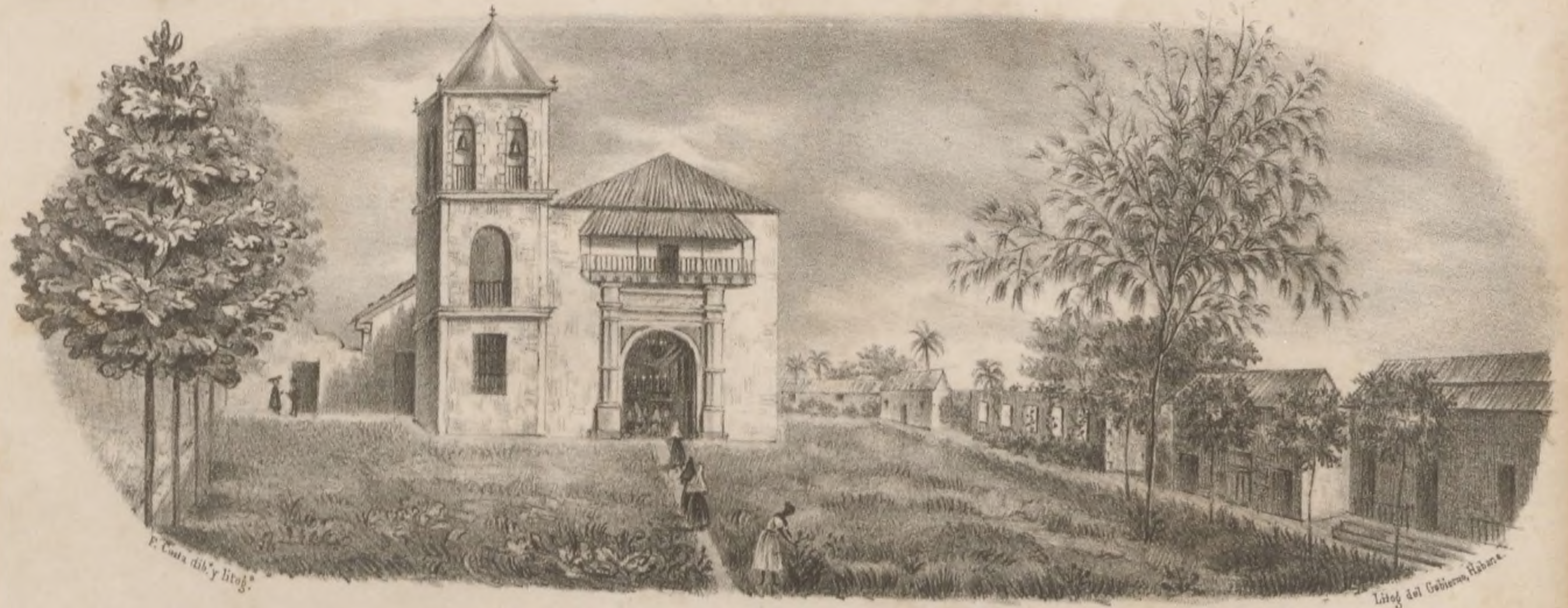
IGLESIA DE LA VILLA DE SAN ANTONIO ABAJ.
