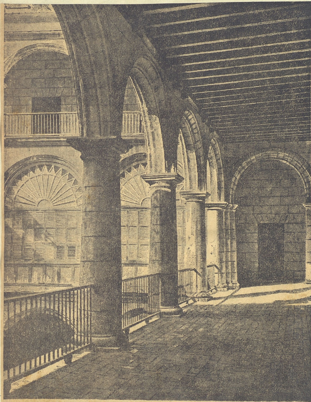
Vista de un ángulo de una de las galerías que da a uno de los dos patios del ex convento de San Francisco, edificio de gran valor arquitectónico e histórico próximo a ser parcialmente desocupado por el Ministerio de Comunicaciones. Entre sus elementos funcionales se destacan las cuatro pes características del estilo colonial cubano: puntal, portal, patio y persianas, adecuados para nuestro clima. En la altura de tres pisos o plantas de esa reliquia cabrían bien seis plantas de mucho menor puntal, pero a base de aire acondicionado. Obsérvese el típico "medio punto" de cristales de color. A. M.
