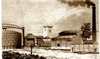
DEPOSITO DEL GAS
