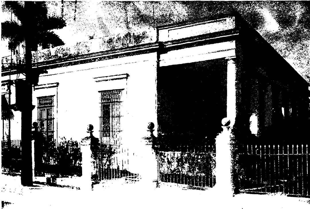
Edificio colonial de la antigua "Quinta de Echarte" situada en la barriada del Cerro.
