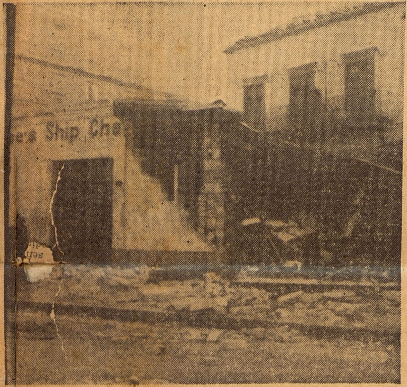
El establecimiento situado en la calle San Pedro, al costado del Ministerio de Agricultura, se derrumbó, destruyendo en su caída los techos y una gran cantidad de mercancías allí depositadas.
