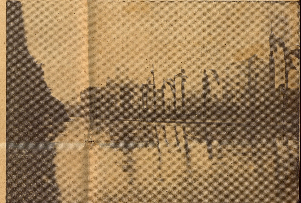
Las palmas que adornan la Avenida de las Misiones han quedado totalmente peladas, manteniéndose milagrosamente en pie y dando un aspecto desolado a ese hermoso lugar.
