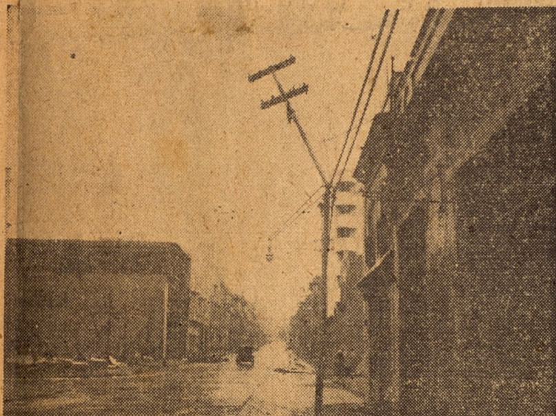
En la esquina de Marina y San Lázaro la terrible fuerza del huracán partió en dos un poste del alumbrado eléctrico. La parte superior permanece sujeta a los cables.
