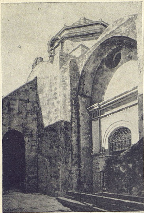
Contrafuerte de la iglesia
